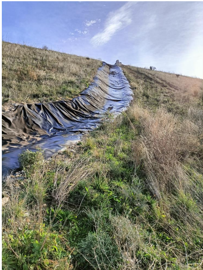
Point d'observation 2 : Ravines importantes en partie supérieure de talus avec mise à nu du DEDG
