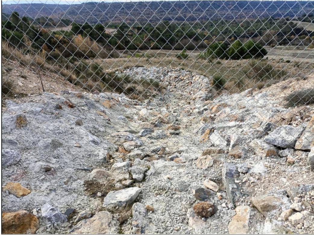
Point d'observation 8a : exutoires avec enrochements bétonnés
