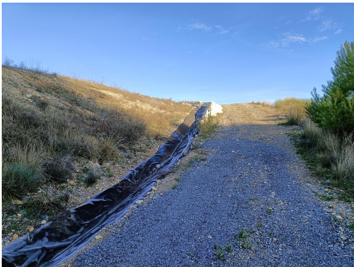
Point d'observation 1 en décembre 2022 : aménagement d'un muret de canalisation des eaux en partie haute
