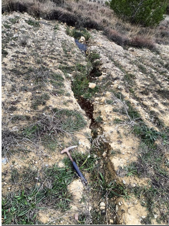
Point d'observation 2 : Ravines importantes en partie supérieure de talus avec mise à nu du DEDG
