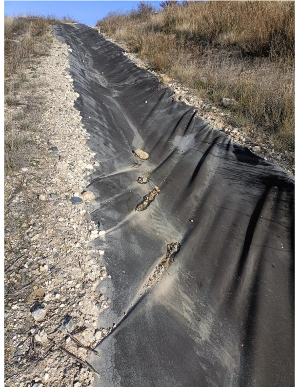
Points d'observation 6 : Ouvrages de gestion des eaux avec défauts d'intégrité (soudures, trous...)
