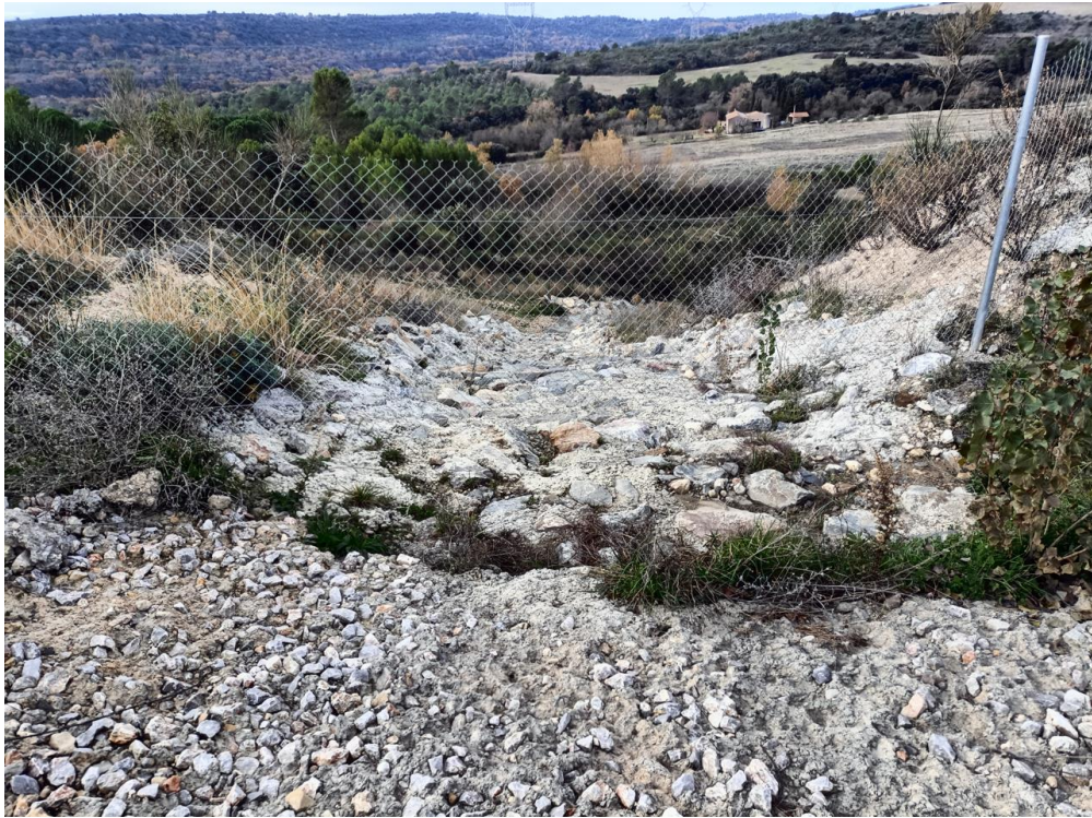
Point d'observation 8b : exutoires avec enrochements bétonnés
