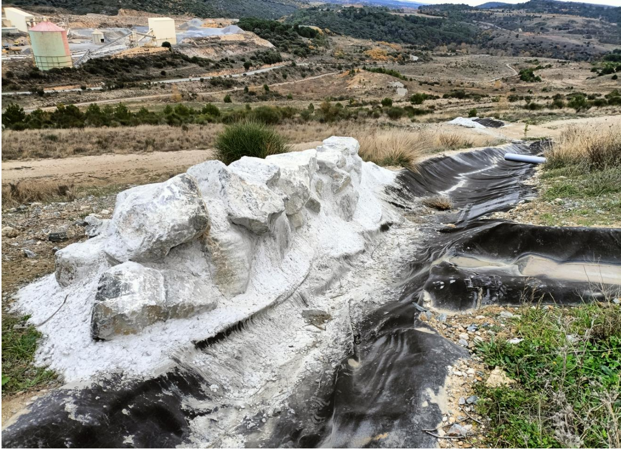
Point d'observation 12 (janvier 2012) : point 12 après aménagement d'un mur pour canaliser les écoulements et limiter les phénomènes d'érosion
