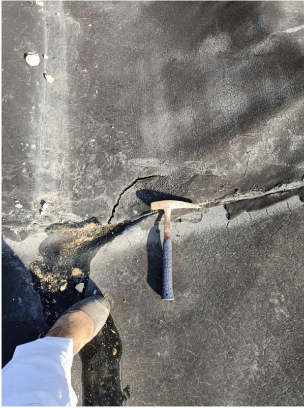
Points d'observation 6 : Ouvrages de gestion des eaux avec défauts d'intégrité (soudures, trous...)
