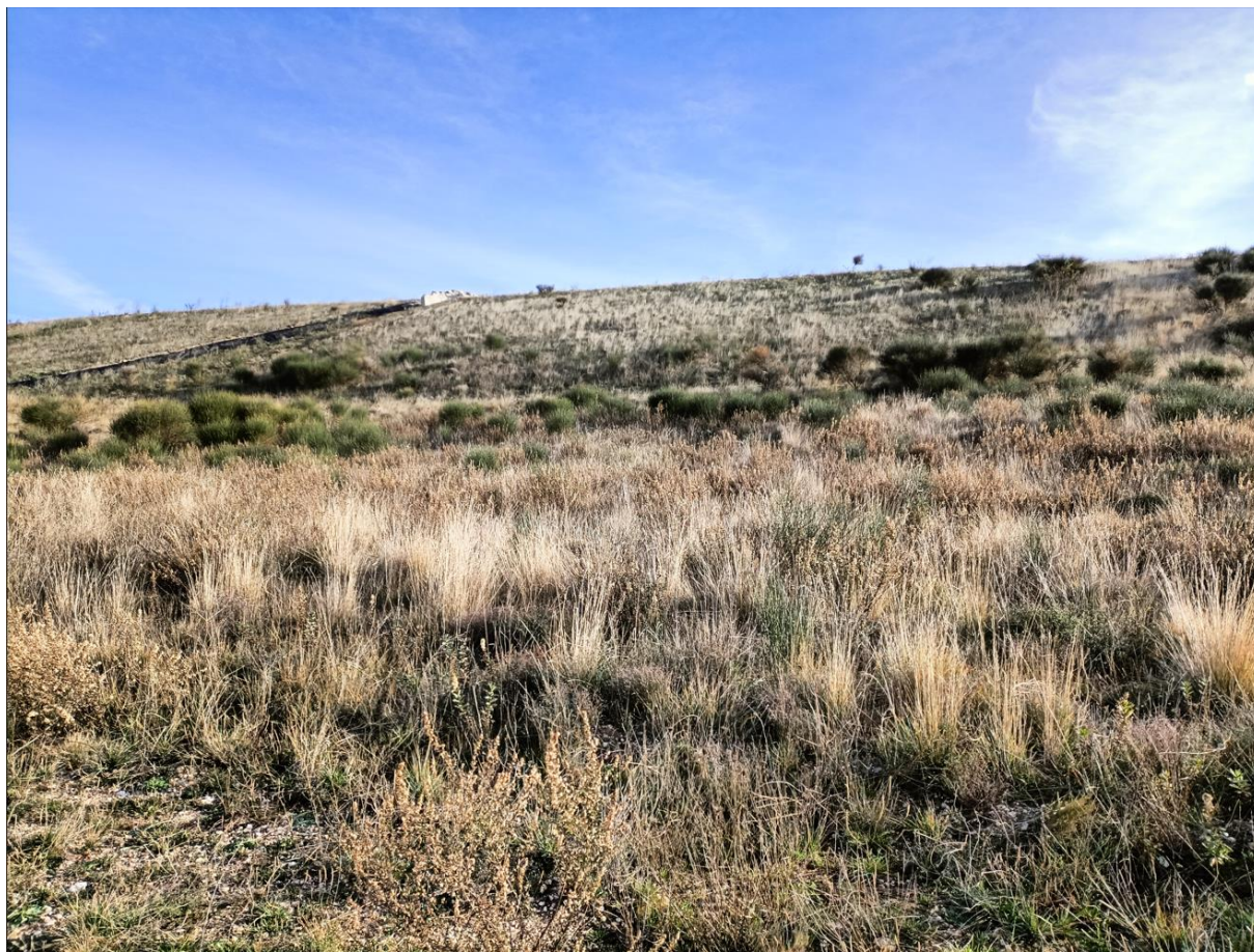
Points d'observation 5 : Ancienne zone instable sans évolution notable depuis son traitement en 2007
